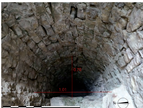
Figura 14. Detalle del interior de la galería septentrional. Obsérvense las huellas del encaje de la cimbra y cómo coincide la línea de imposta con la roca natural.
