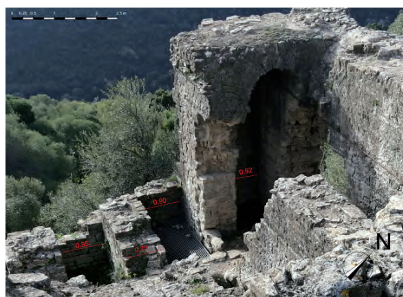
Figura 16. Detalle de los tres tramos centrales al oeste. Se puede observar cómo se conserva la bóveda más septentrional y el arranque de la central.
