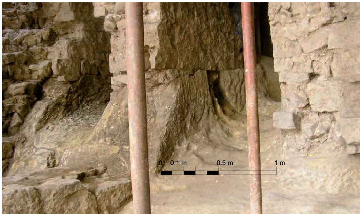
Figura 10. Detalle del proceso de talla de la roca natural para apoyar los lienzos y facilitar el paso.
