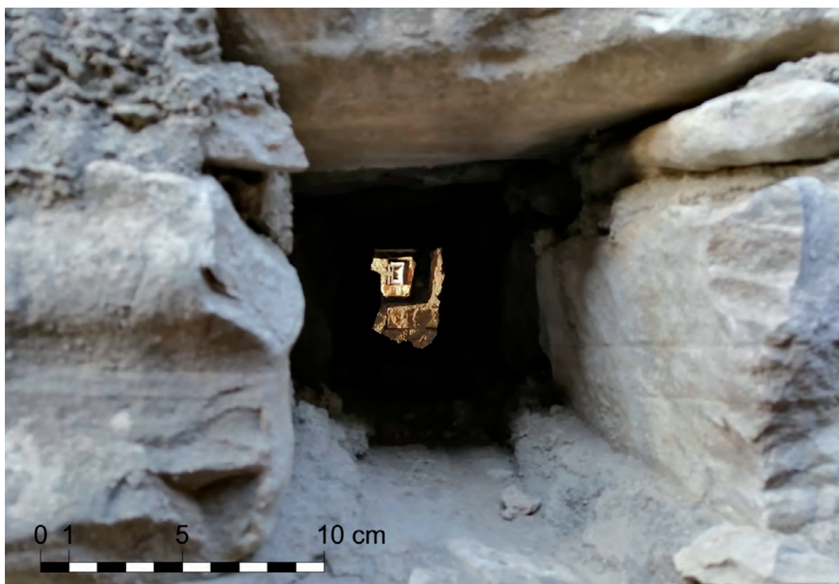
Figura 22. Mechinal oblicuo con conexión con otros mechinales en los lienzos paralelos.
