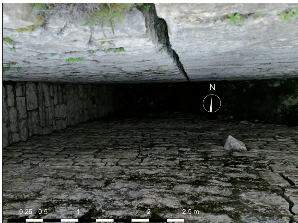
Figura 21. Imagen de la galería 3 excavada, en la que se puede observar el interfaz de adosamiento de los pequeños muros trabados con la fachada al muro meridional de la estructura central. En el lienzo paralelo continuo, se aprecia una de las pequeñas piedras que sobresalen del aparejo.
