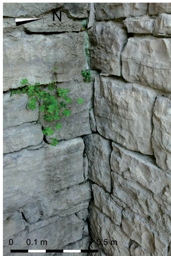
Figura 19. Detalle del encastre entre la fachada oeste y uno de los pequeños muros que se adosa al muro perpendicular occidental.
