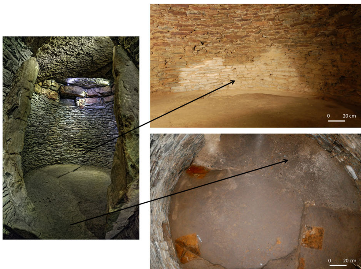
Figura 5. Interfaces de reparación en muro y pavimento de la cámara.
