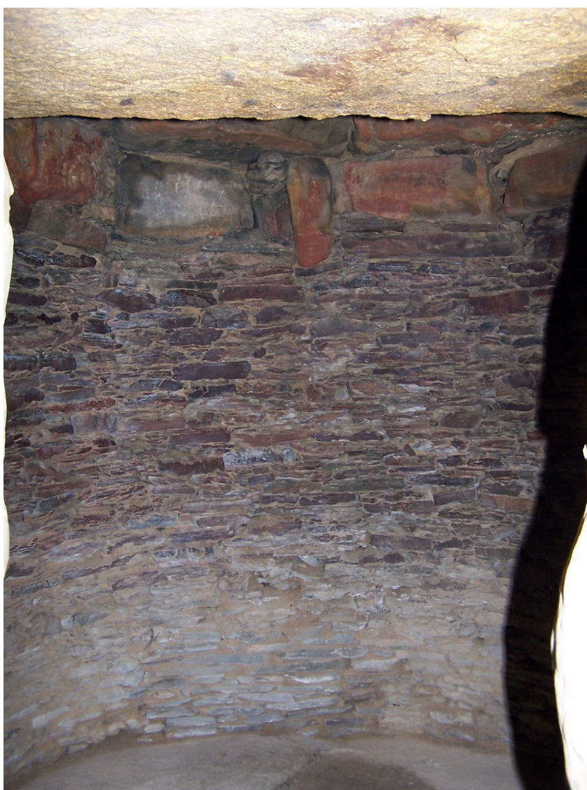
Figura 14. Tonos rojizos apreciables en la superficie exterior de los muros de la cámara.
