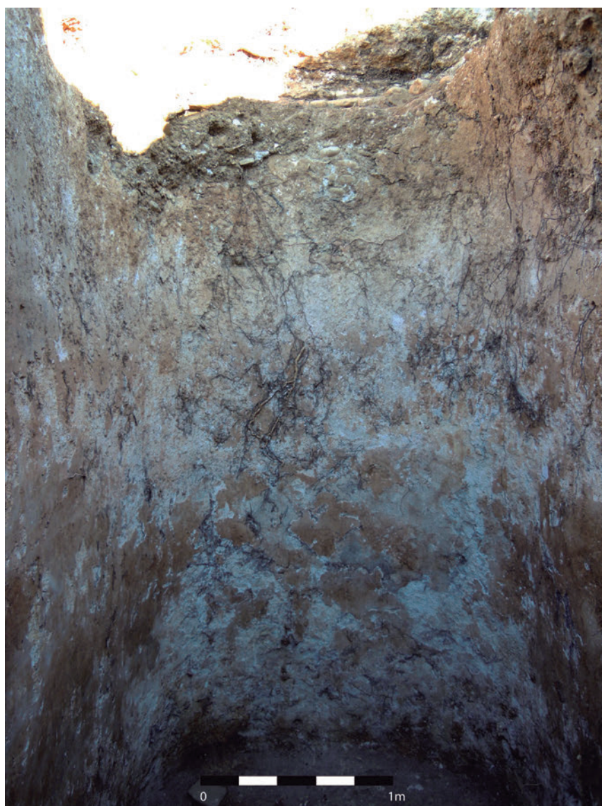
Figura 4. Aspecto da cabeceira Norte da cisterna de Monte Molião, onde se aprecia o bom estado de conservação da estrutura e do seu revestimento interno.
