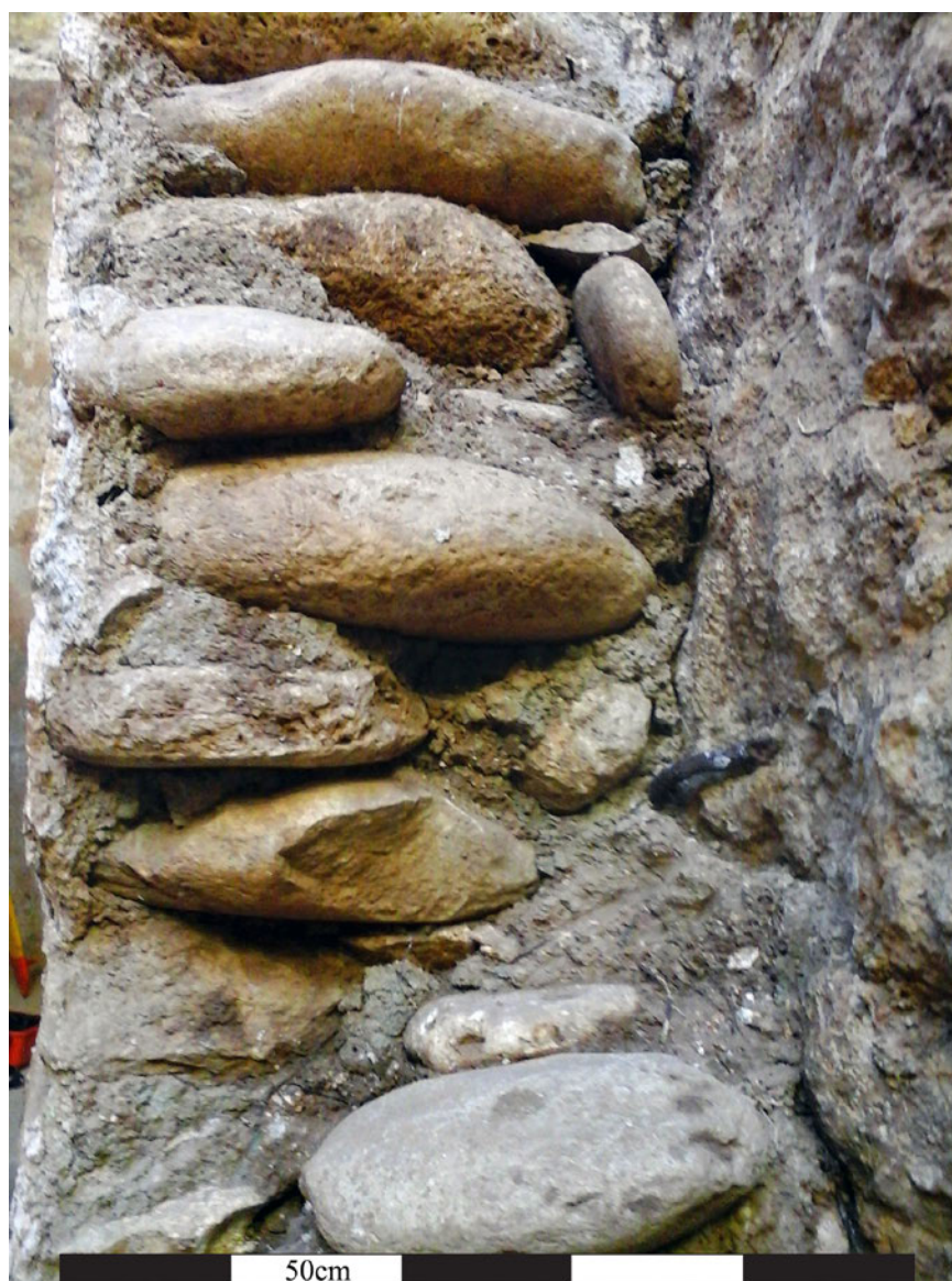
Figura 6. Estrutura de alvenaria e revestimento da cisterna visto em corte na interface da violação do século XIX.
