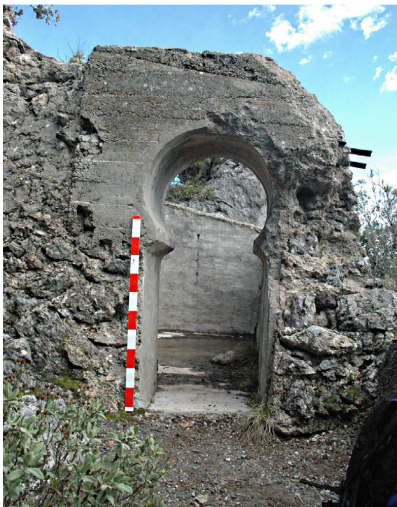
Figura 30. Entrada a la caseta de la posición 234-Alonso. A la derecha del macizo de hormigón que conforma el arco de herradura sobresalen dos piquetes de alambra que hacen las veces de armadura.
