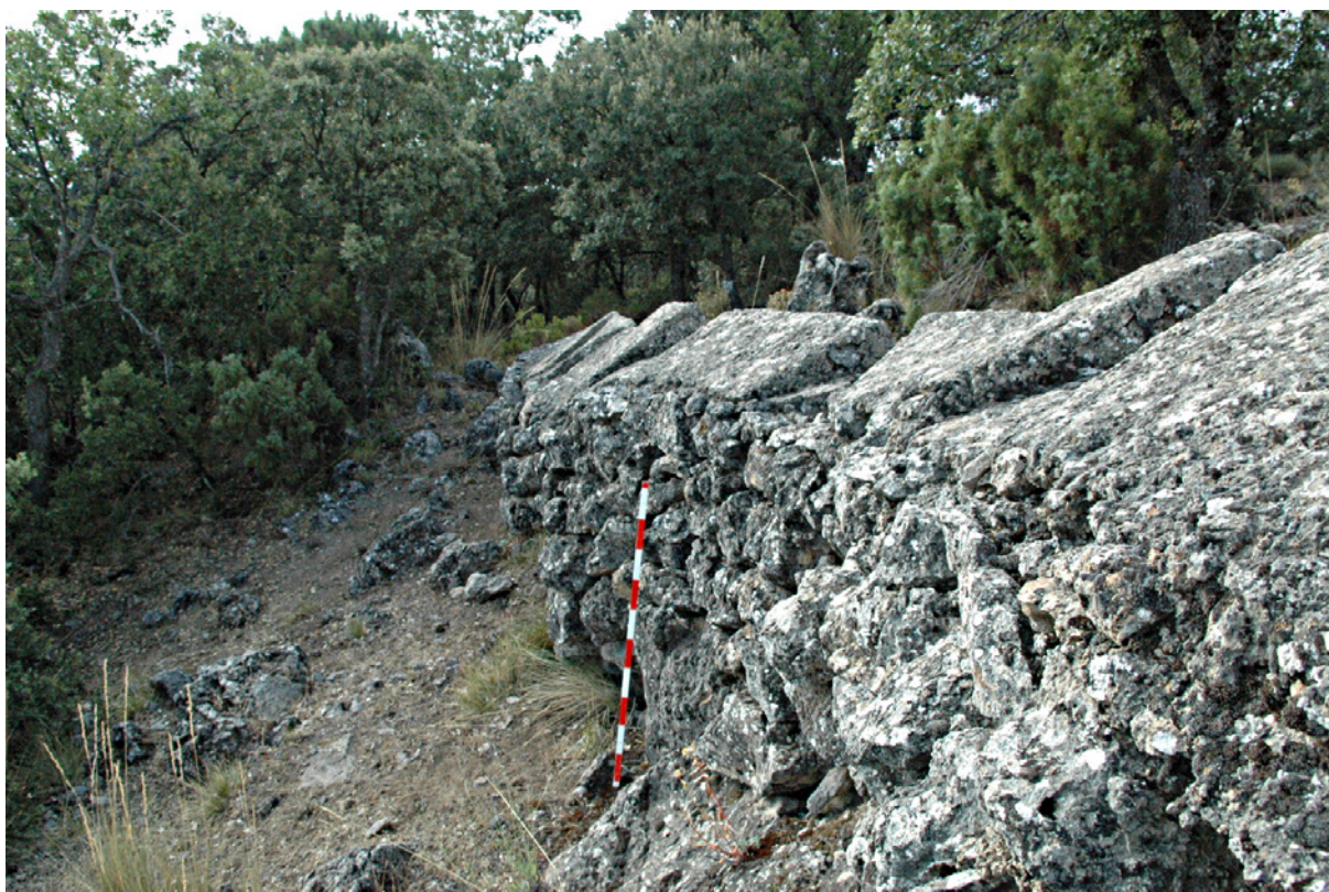
Figura 26. Muro parapeto de mampostería con almenado de hormigón. Posición 101-Cerro Garay.
