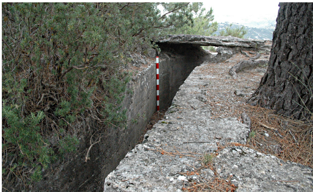
Figura 32. Trinchera de comunicación con restos de la cubierta de hormigón. Posición 100-Los Pocicos.
