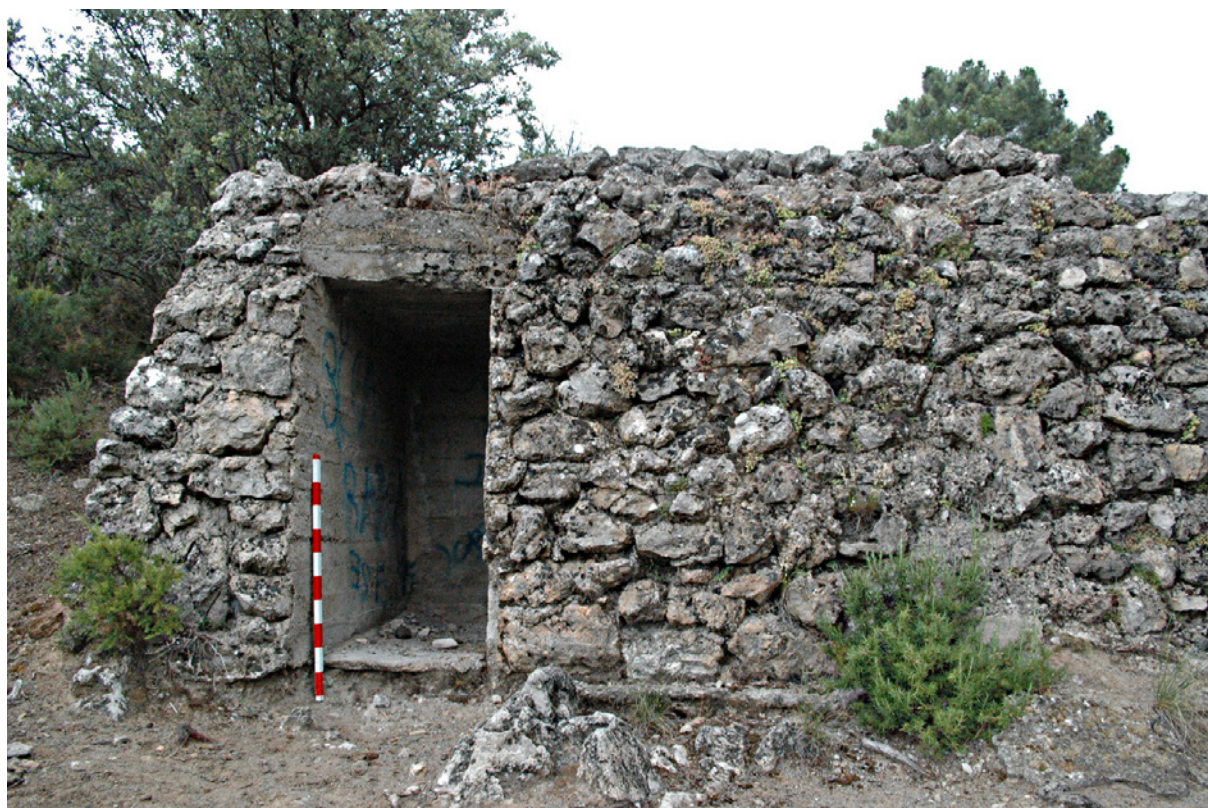
Figura 28. Refugio contra artillería. Posición 100-Los Pocicos. Construido con hormigón revestido de mampostería.
