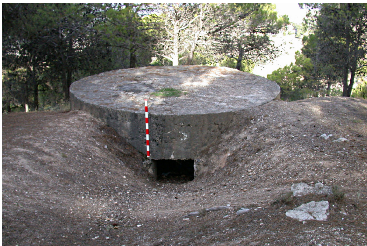
Figura 27. Nido de ametralladora construido con hormigón armado. Posición 310.
