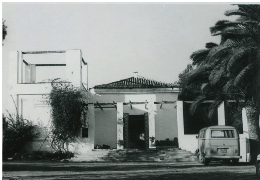
Figs. 9. Fachada de la Casa-Museo demolida en los primeros años de 1970, sustituida por la actual sede institucional del Conjunto Museo. Archivo del Conjunto Arqueológico de Itálica.
