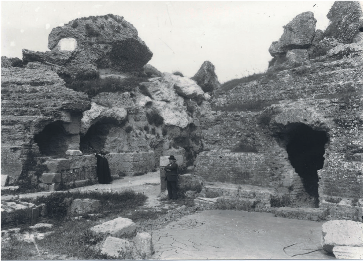
Figura 7. Fotografía de R. Salas tras el inicio de las excavaciones emprendidas por A. Parladé en la primera mitad de la década de 1920. Colección J.M.R. Hidalgo.
