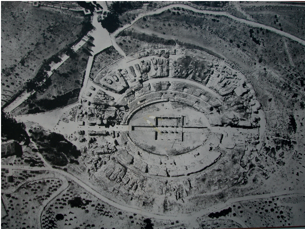
Figura 12. Fotografía aérea del Anfiteatro, 1983. En ella se aprecian los trabajos de restauración en la fachada principal y también los del cuadrante sureste del podium .
