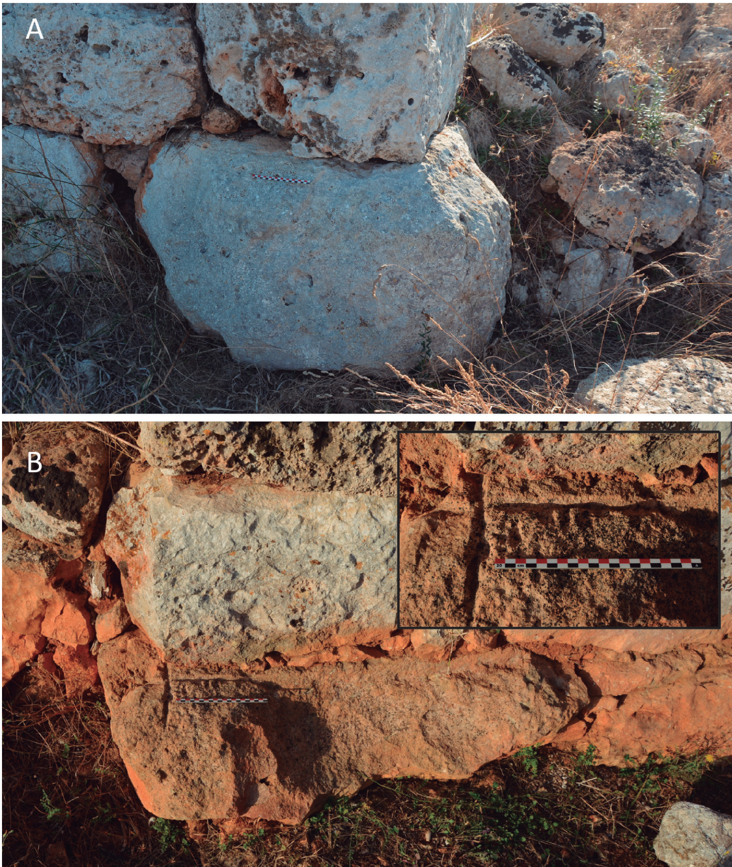
Figura 10. Guías en sillares basales documentadas. Fuente: Proyecto Modular.
