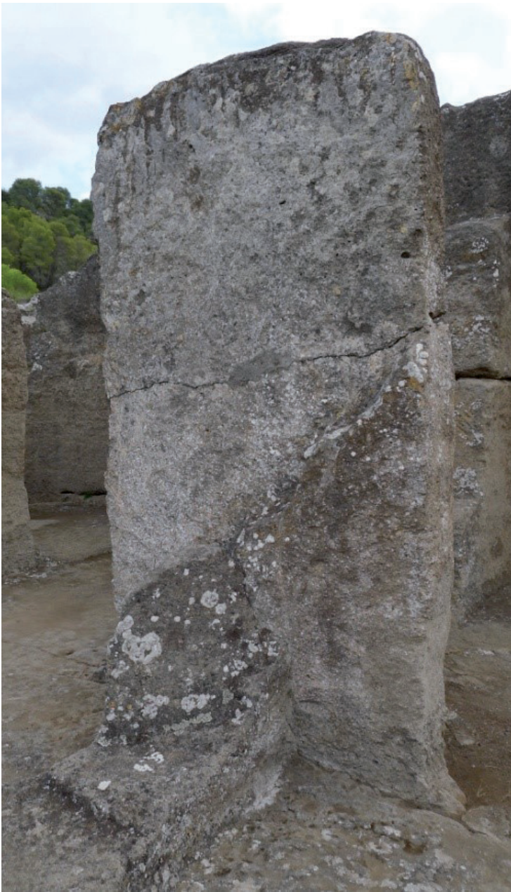
Figura 6. Pilar cruciforme septentrional (A115, altura 3.14 m, ancho 2 m) fracturado por la superficie carbonatada en su cara norte.
