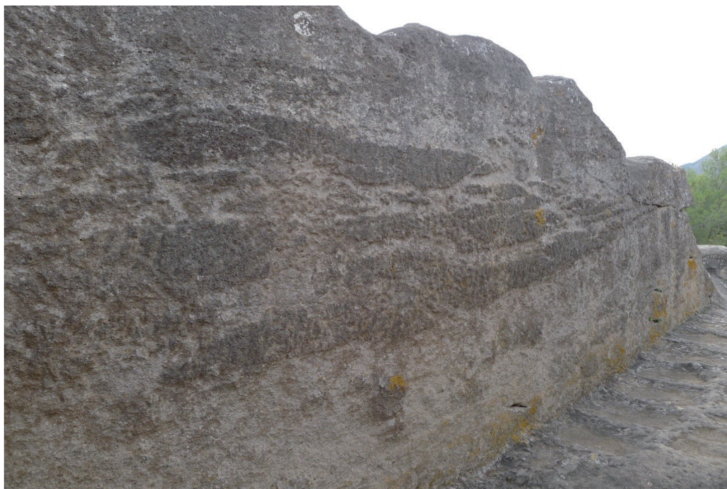
Figura 7. Restos de las huellas de las herramientas de trabajo en el interior del muro sur del aula (A104, altura 2.40 m) y marcas de la extracción de sillares en el nivel de uso de la nave meridional.
