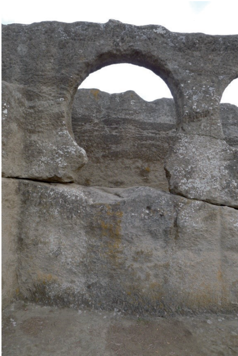
Figura 10. Detalle de las rozas de los pilares (A117, ancho 60 cm, altura 2.14 m) y tallado del arco oriental de la arquería sur (intercolumnio de 1.60 m).
