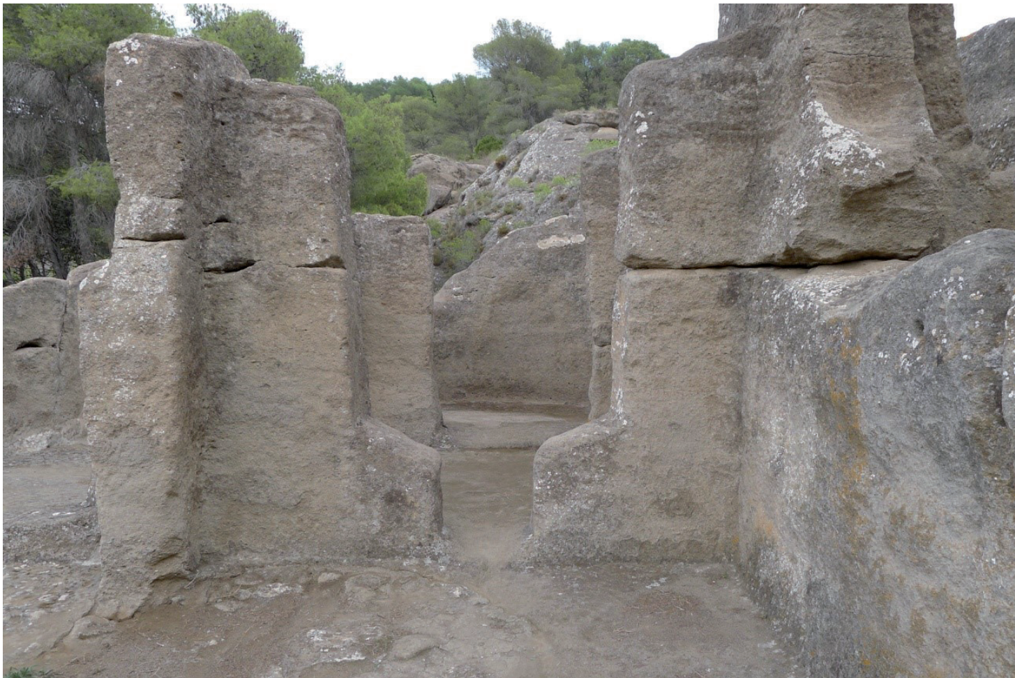
Figura 9. Vista desde el oeste de los pilares/jambas de separación (A116, altura máxima 3 m) entre la nave central (ancho 3 m) y el tramo del transepto, así como diaclasa horizontal que recorre los alzados a media altura (2 m desde el suelo).
