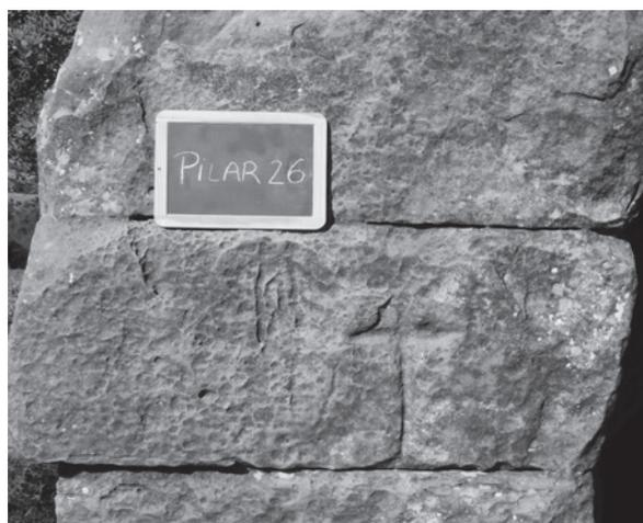
Figura 21. Detalle de marcas de cantero sobre sillares del tramo de pilares del acueducto (Foto: P. Faus).
