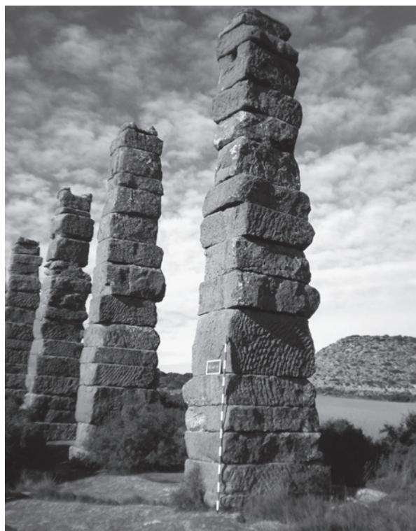
Figura 20. Detalle del trabajo de labra de los sillares de los pilares del acueducto (Foto: P. Faus).
