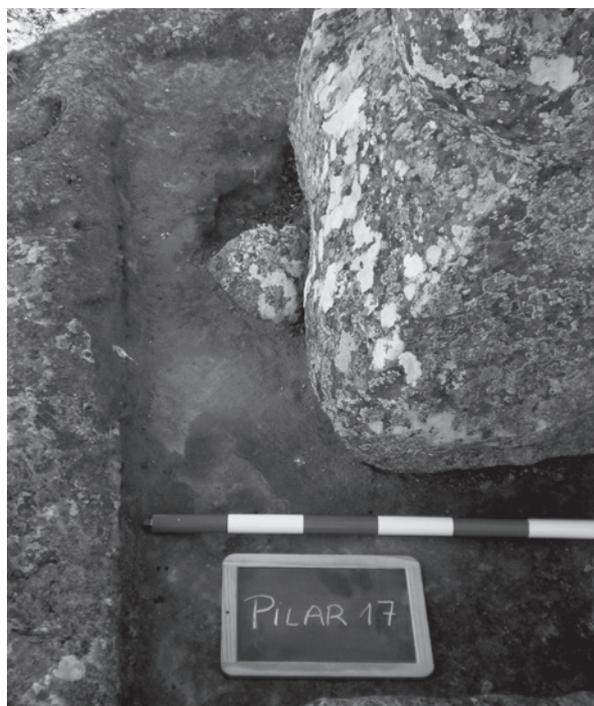
Figura 18. Detalle del rebaje en roca para la cimentación y apoyo de los pilares del acueducto (Foto: P. Faus).
