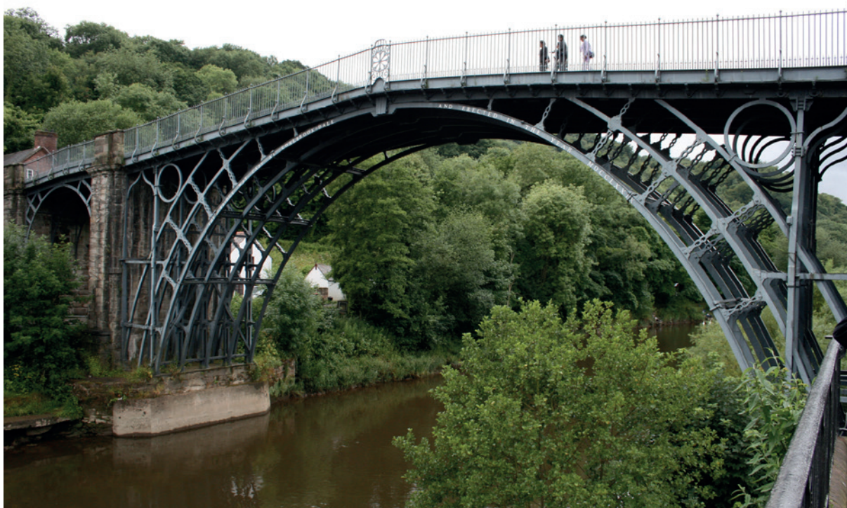
Lámina 2: El primer puente de hierro a gran escala construido en el mundo, corazón del Ironbridge Gorge Museum.
