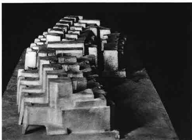
H. DE FRIES, BERLIN - MODELLENTWURF ZUR EXPORTMESSE IN HAMBURG 1925 Grundriss siehe Seite 22 - Gebäudelänge 36 m - Breit aufgesetzene Baukörper sichern größtmögliche Lichtzufuhr - Keine geschlossenen Höfe - Anstellplätze und Stützpunkte im Doppelstocksystem - Große Liegeflächen im Gebäudewesen - Dreiwöchentliche Anlagereparaturen über das Straßenniveau - Treppenhäuser mit direktem Zugang von mehrgeschossigen Baumaterial
