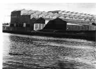
DIESELMASCHINENFABRIK DER SCHIFFSWERFT HARLAND & WOLFF LTD., GLASGOW Eisenkonstruktion, Holzbauweise, Glasdächer Phot. H. Wittner
