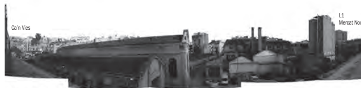
Fachadas desde cota cajón - Zona Mercat Nou
