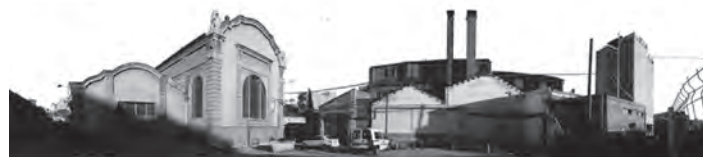
Fachadas desde cota calle - Zona Mercat Nou
