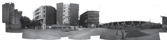
Fachadas 360° desde cota calle - C/ Antoni Capmany
