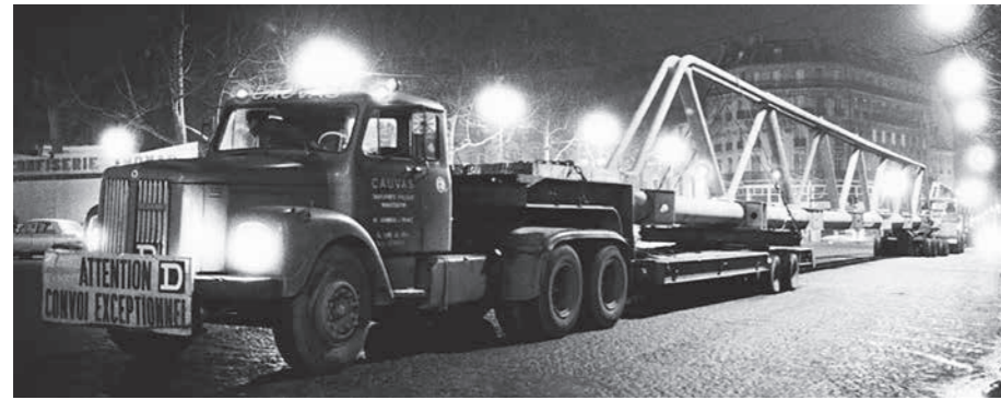
8. Construcción del Centre Pompidou, transporte de la estructura, París, 1971-1977.
