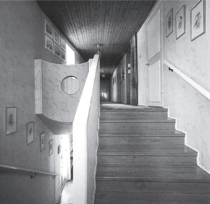
A partir de este punto mantiene la anchura hasta llegar a la planta superior. De ello se deducen dos informaciones: la primera, que en el rellano no realizamos una media vuelta completa y, la segunda, que las paredes en donde se encaja dicha escalera no pueden ser totalmente paralelas. La escalera, además de conducirnos arriba, trata de “in-formarnos” de ponernos en suerte para una experiencia venidera (figura 8).
