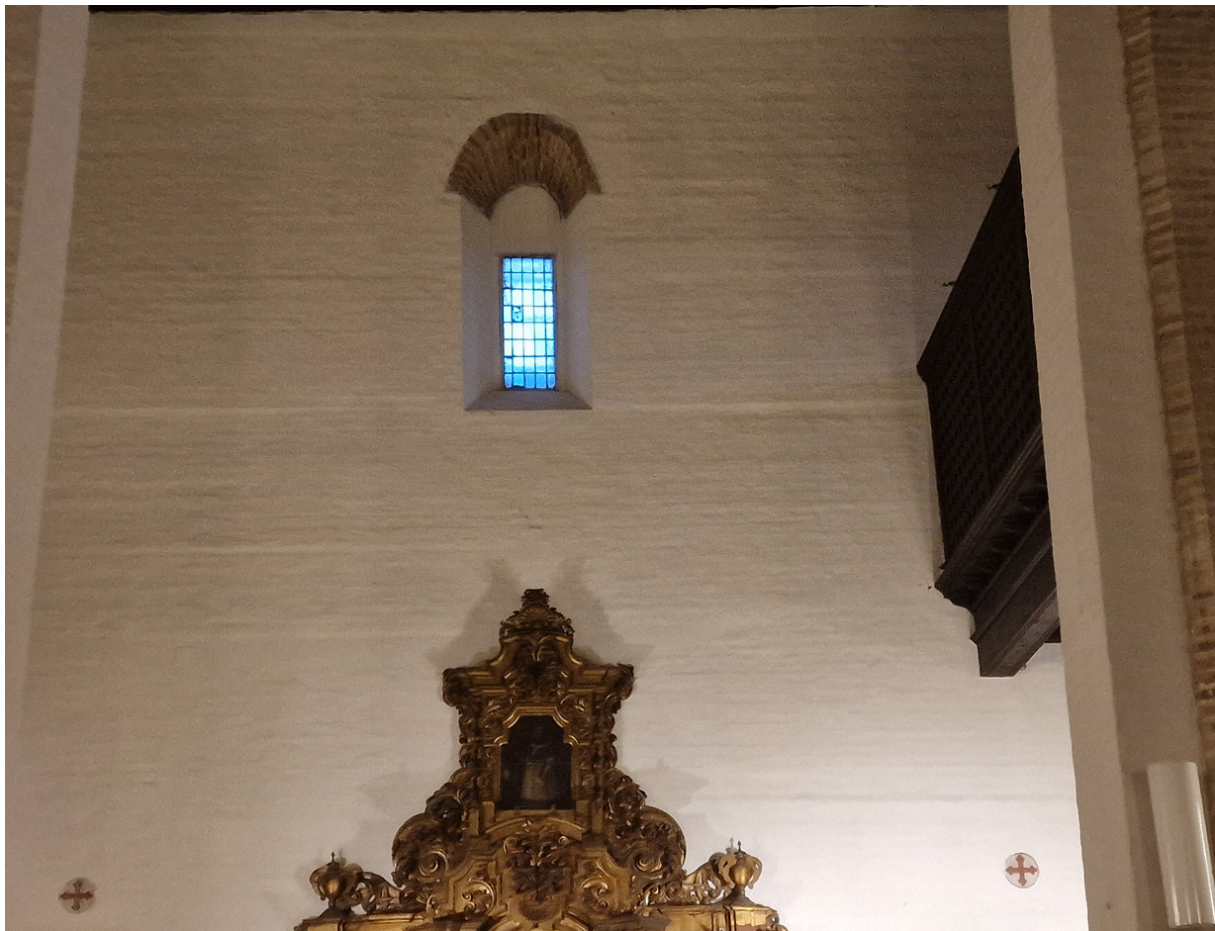
Lám. 13- Iglesia de Omnium Sanctorum, detalle de la lectura paramental en el interior con el recremento del muro que exigió el derribo de los primeros pilares y arcos túmidos y la edificación de nuevos pilares ojivales en 1356. Esa obra de reedificación tuvo un fuerte impacto dejando inutilizado el edificio entre 1355 y 1360-61.
