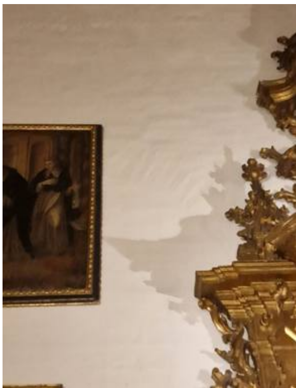
Lám. 14- Iglesia de Omnium Sanctorum, detalle de la lectura paramental en el interior con la altura de los arcos originales de la iglesia del siglo XIII, reedificada y sin uso entre 1355 y 1360-61.
