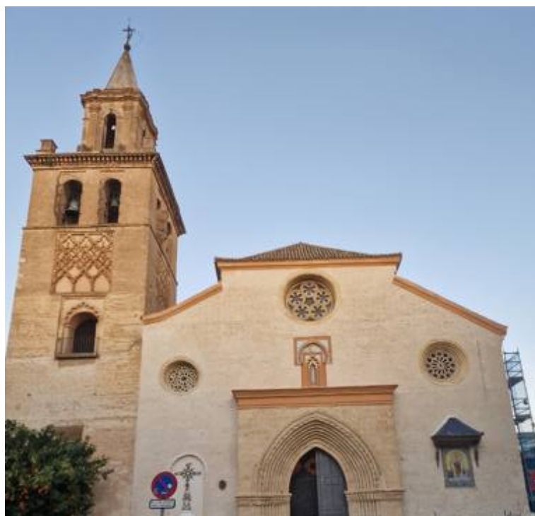
Lám. 9- Fachada de la iglesia de Omnium Sanctorum. La retirada del mortero de cal permite hacer una lectura paramental y deducir el alcance de la reedificación de Pedro I en 1356.
