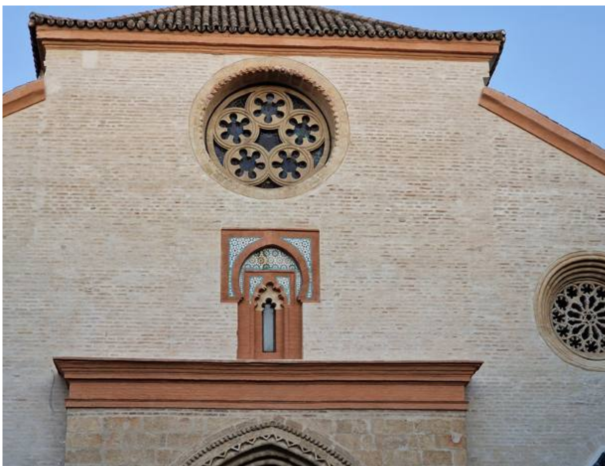
Lám. 10- Iglesia de Omnium Sanctorum, detalle de la sustitución del hastial por una cubierta a un agua de ascendencia nazarí.
