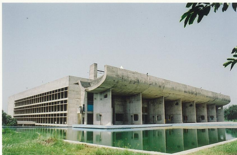
Marquesina Congreso de Chandigarh (Le Corbusier)
