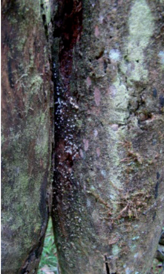
Figure 1. Dos postes colonizados por microorganismos
