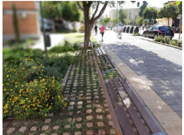
Fig. 17. Avda.El Greco. Pavimento drenante.
