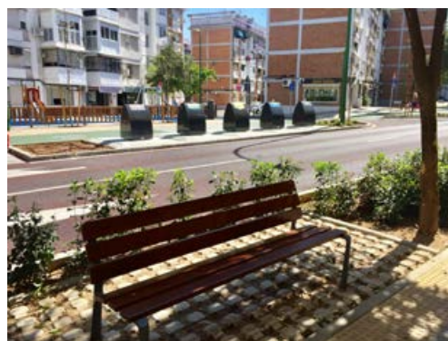
Fig. 16. Fotografías del estado actual de la Av. El Greco
