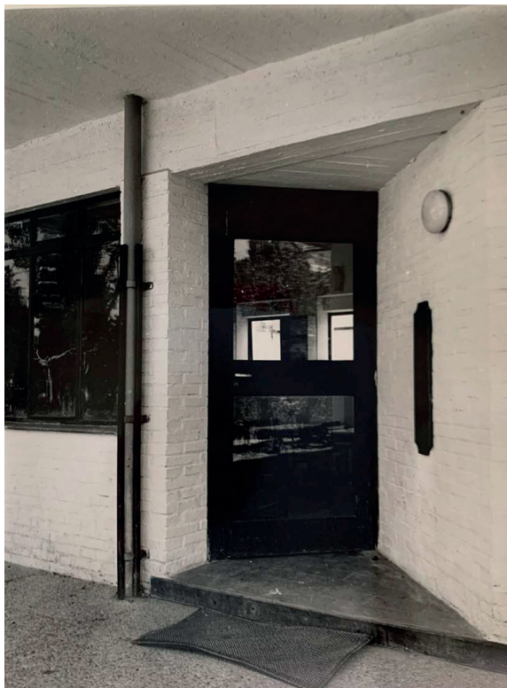
Fig. 6 Acceso a las aulas en el colegio Aula Nueva. Autor: Portillo. Fuente: Fondo Antonio Fernández Alba, Servicio Histórico, Fundación Arquitectura COAM. Elaboración propia.
