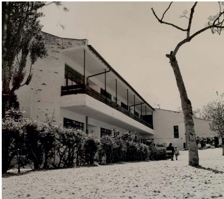
Fig. 5 Exterior del tránsito al aire libre en el colegio Aula Nueva. Autor: Portillo. Fuente: Fondo Antonio Fernández Alba, Servicio Histórico, Fundación Arquitectura COAM. Elaboración propia.
