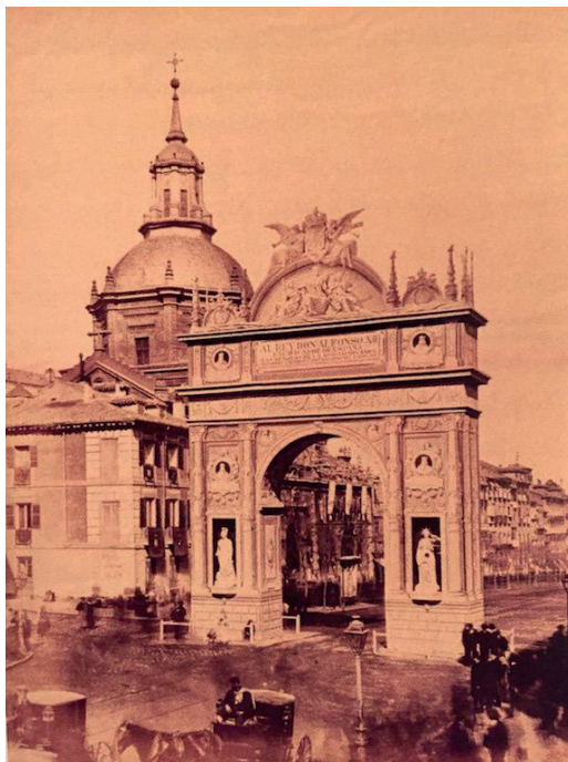
Fig. 3. Jean Laurent. Arch of Calle Alcalá. 1876
