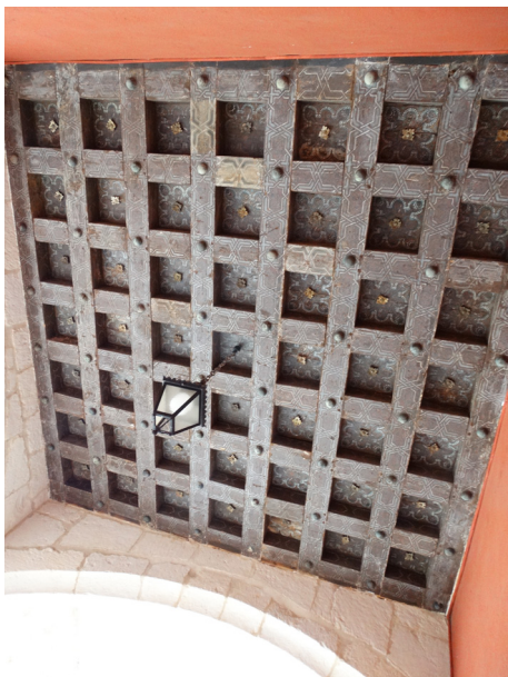
Figura 8. Crujía Noreste con resto de alfarje del corredor bajo. Palacio del Infantado, Juan Rodríguez de Segovia, c. 1485.
