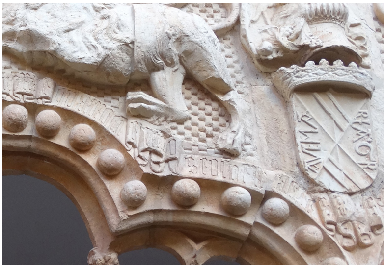
Figura 2. Detalle «quatrocientos ochenta e tres» como producto de una restauración.
