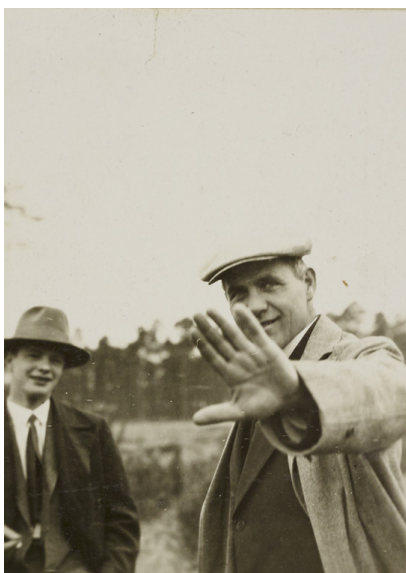
Figura 16. Meyer, director de la Bauhaus, supervisando la construcción de la escuela sindical ADGB en Bernau (1928).
