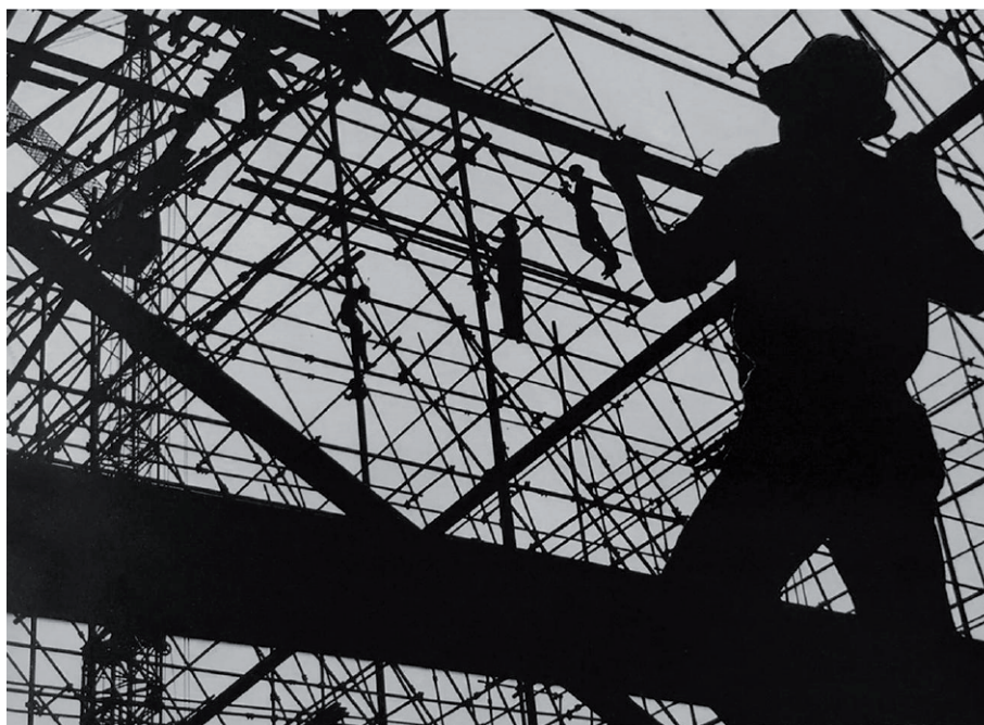
Figura 1. Montagem da estrutura metálica para a construção das fábricas da União Fabril do Azoto da Companhia União Fabril, no Lavradio. Fotografia de Augusto Cabrita.
