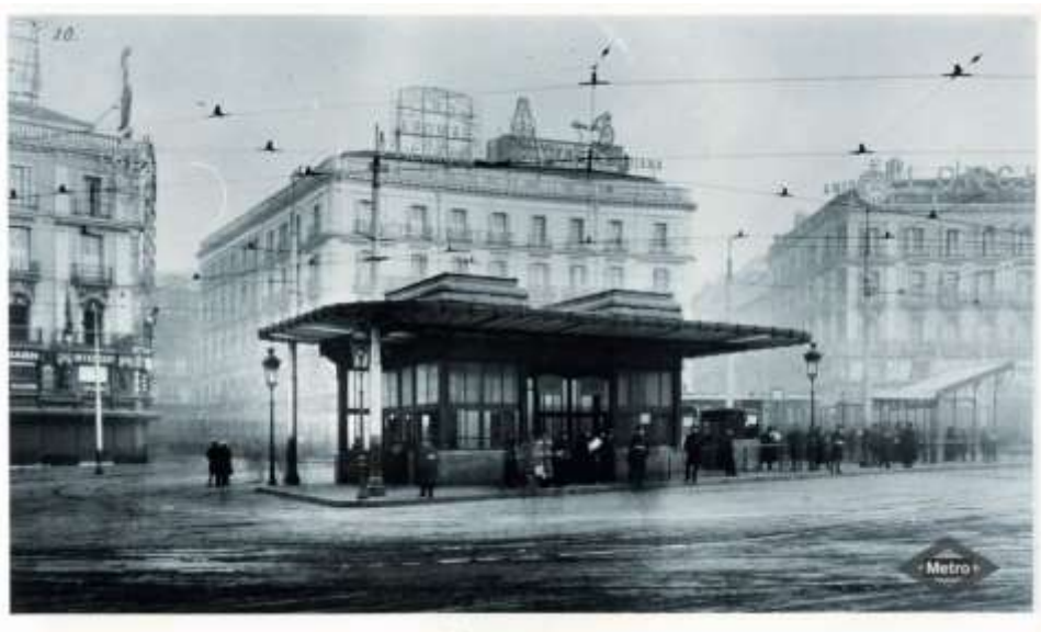
Figura 5. Anuncios luminosos sobre edificios de la Puerta del Sol de Madrid, 1920. (Fuente: Archivo fotográfico de Metro de Madrid. Sig.: MetroMadrid_2761. Fotografía digitalizada y disponible en www.memoriademadrid.org )
