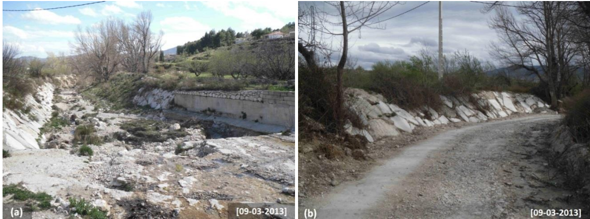
Figura 8. (a) Inicio del tramo II2 caracterizado por una sección en artesa y el recrecimiento del cauce con motas de tierra; (b). Margen cóncavo confinado por el trazado de un camino de tierra compactada y la protección de una escollera (tramo II2).
