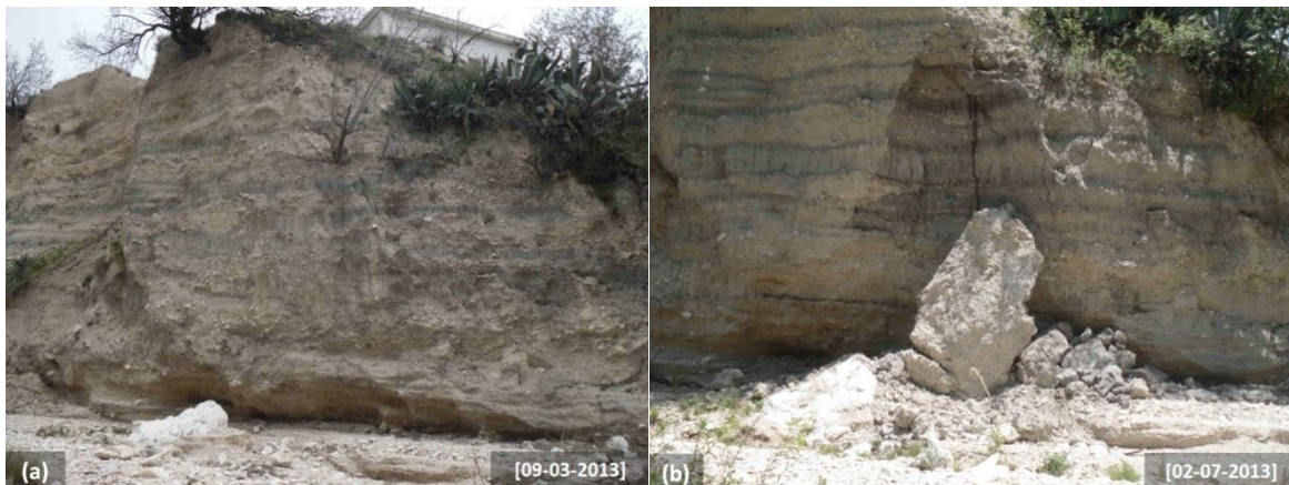
Figura 7. Ejemplo de margen compuesto de materiales poco cohesivos que favorece el ensanchamiento del cauce en los sectores no protegidos con escolleras del tramo II1: (a) socavado basal, y (b) desmoronamiento.
