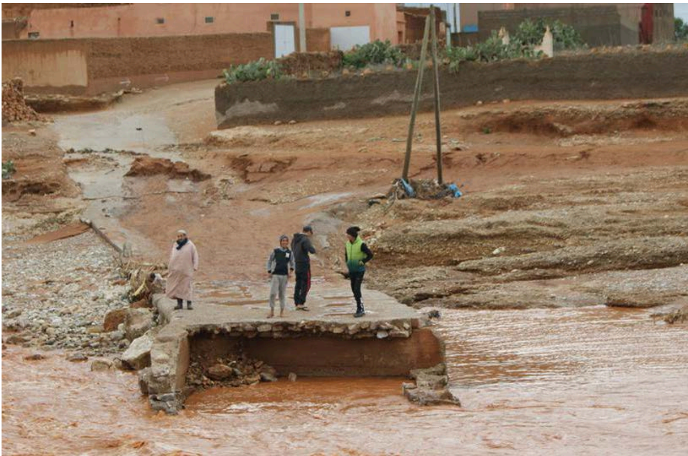
Photo 8. Pont détruit par les crues de novembre 2014 au niveau d'El Aouina. Source: https://tiznit24.com
