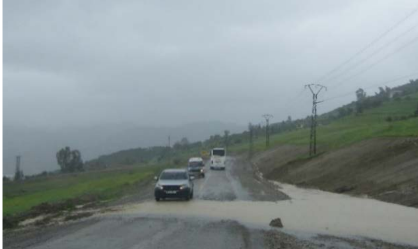
Photo 3. L'accumulation des eaux de pluie au-dessus de tronçon routier, due à l'insuffisance et à l'inefficacité des systèmes de drainage. Est un phénomène plus fréquent dans le Rif central méridional. La photo prise de pk 144+100 de la route régionale 408. Source: auteurs, Cliché le 13 avril 2018.
