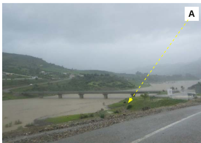
Photos 1 et 2. Hauteur importante de débit au niveau du pont de Ourtzagh (photo A au pk 144+500) et l'impact de l'eau imbibé sur le pied de versant étudié et sur le tronçon routier en question (photo B au pk 143+60). Source: auteurs, Cliché le 10 avril 2018.
