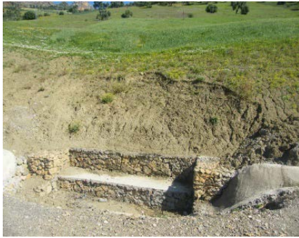
Photo 4. Coulées de boue affectés les gabions et les canaux de drainage. Source: auteurs, Cliché le 19 avril 2019
