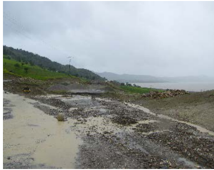
Photo 5. Détérioration et affaissement violent du tronçon routier. Source: auteurs, Cliché le 10 avril 2018
