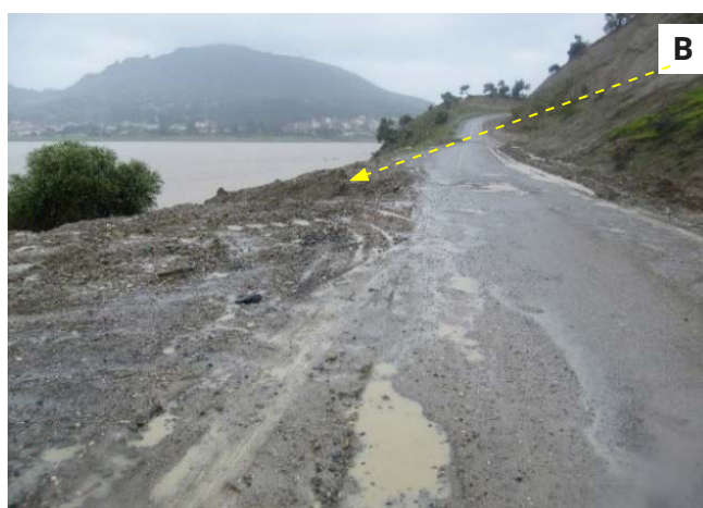
Photos 1 et 2. Hauteur importante de débit au niveau du pont de Ourtzagh (photo A au pk 144+500) et l'impact de l'eau imbibé sur le pied de versant étudié et sur le tronçon routier en question (photo B au pk 143+60). Source: auteurs, Cliché le 10 avril 2018.
