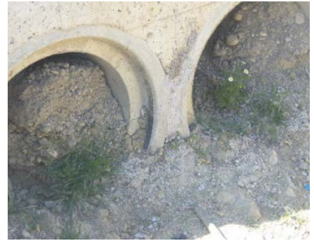
Photo 6. Colmatage total des tubes et des canaux de drainage. Source: auteurs, Cliché le 13 avril 2019
