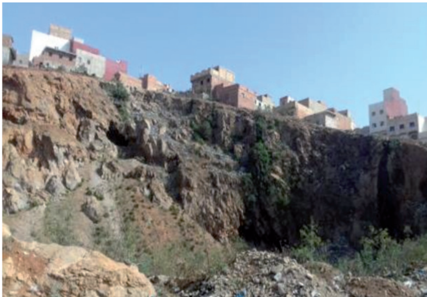
Photo 1. Zone d'effondrement potentiel des cavités, quartier non réglementaire d'Igounaf ville de Nador. Source : El-Amrani, 2017.
