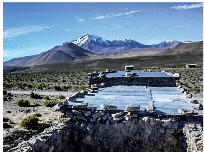
Fotografía 5. Viviendas de adobe con cubierta de planchas de zinc, clavadas a la estructura de cubierta y fijadas mediante piedras. Fuente: Autora.
