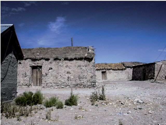
Fotografía 2. Conocimiento aplicado. Estructura exterior de la cubierta compuesta por paños de paja y barro apisonado, en vivienda de muros de piedra. Fuente: Autora.
