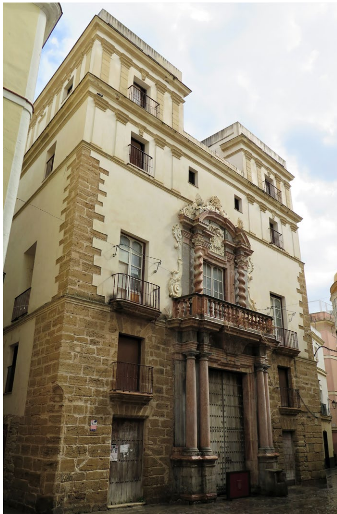
Figura 2. Fachada principal de la Casa del Almirante, estado actual.
