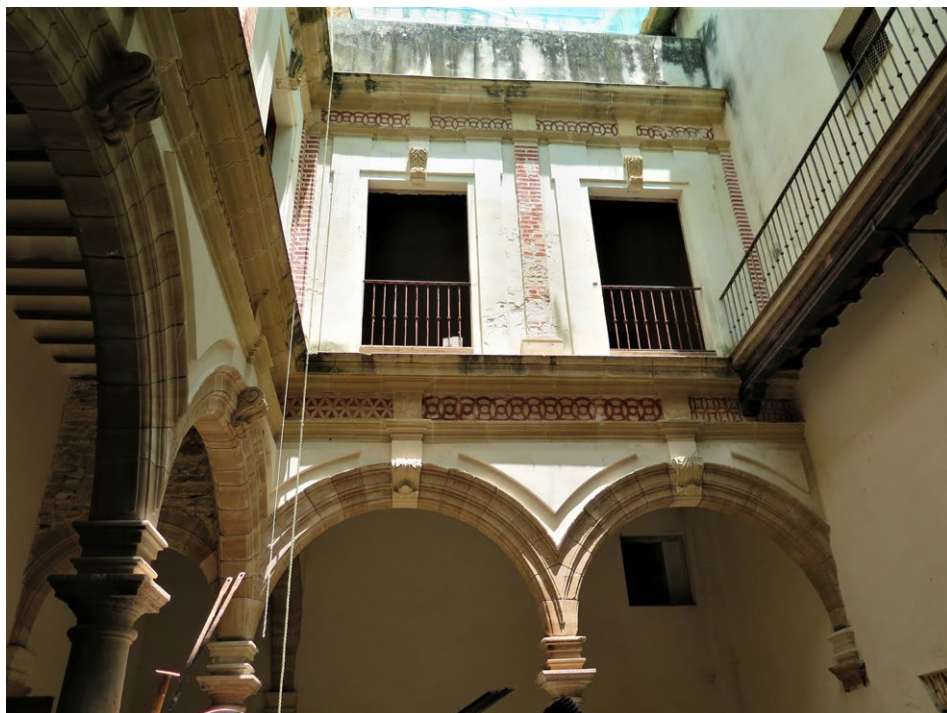
Figura 5. Patio en proceso de restauración con decoraciones recuperadas en frisos y pilastras, © Juan Alonso de la Sierra Fernández.
