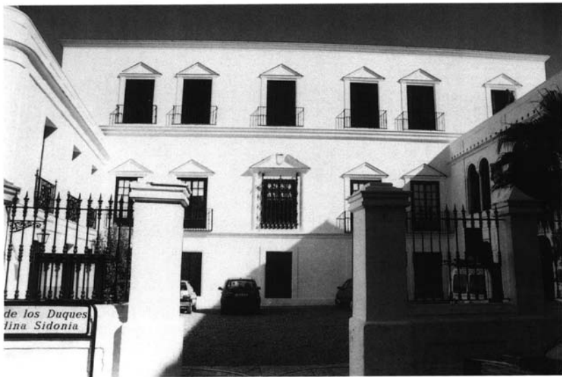
Lámina 2. Palacio ducal de Medina Sidonia. Fachada principal.
