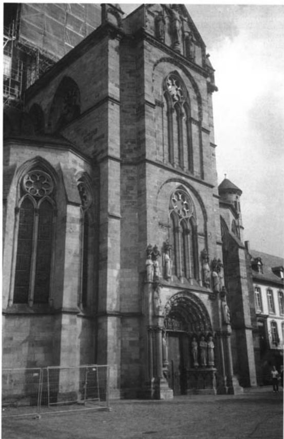
Fotografía 3. Iglesia de Ntra. Sra. de Tréveris. Fachada
