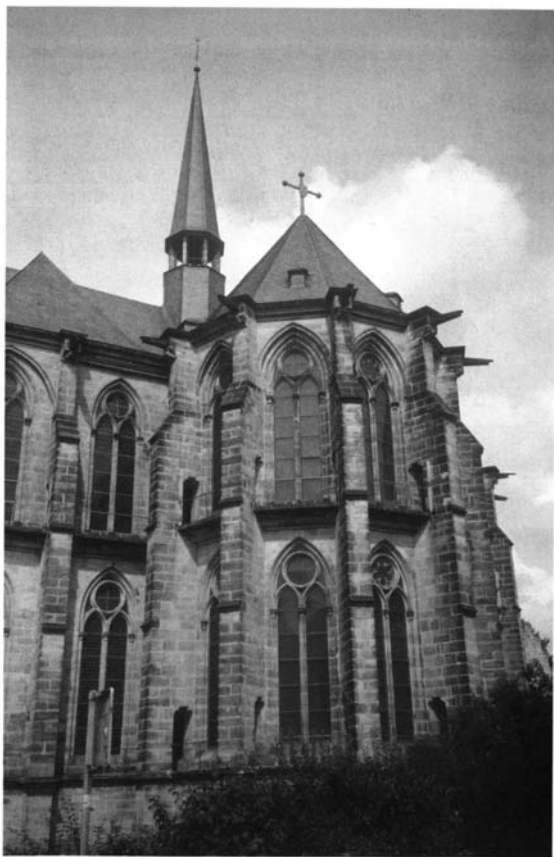
Fotografía 1. Iglesia de Santa Isabel de Marburgo. Ábside Sur
