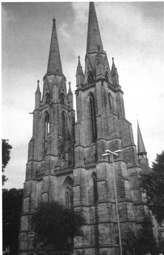
Fotografía 4. Iglesia de Santa Isabel de Marburgo. Torres
