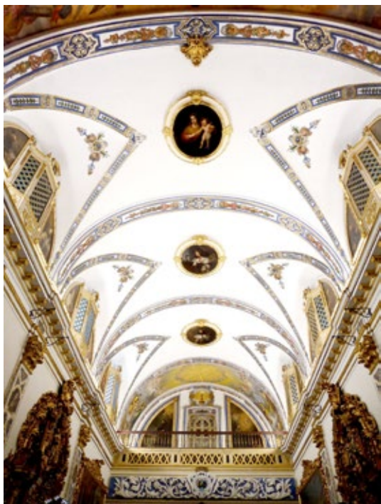
Figura 1. Capilla Palacio de San Telmo. Vista de la bóveda.
