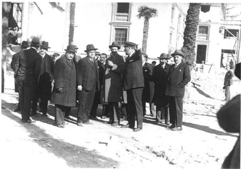
Lámina 7. 1928. Visita a las obras. Zona Teatro. Alfonso XIII, Vicente Traver y Cruz Conde.
