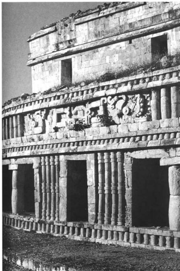
Figura 3- Detalle de la fachada del palacio de Sayil.
