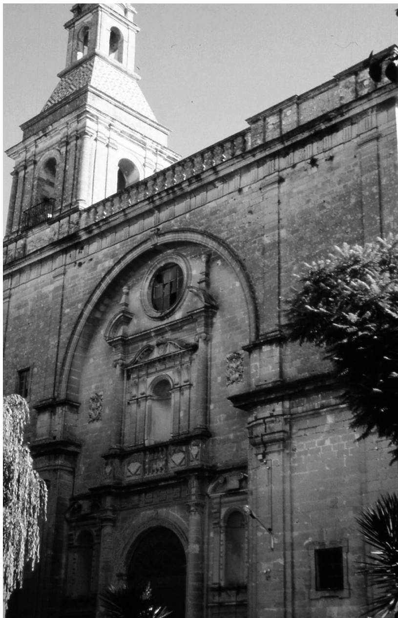
Figura 1. Exterior de la iglesia de San Francisco.
