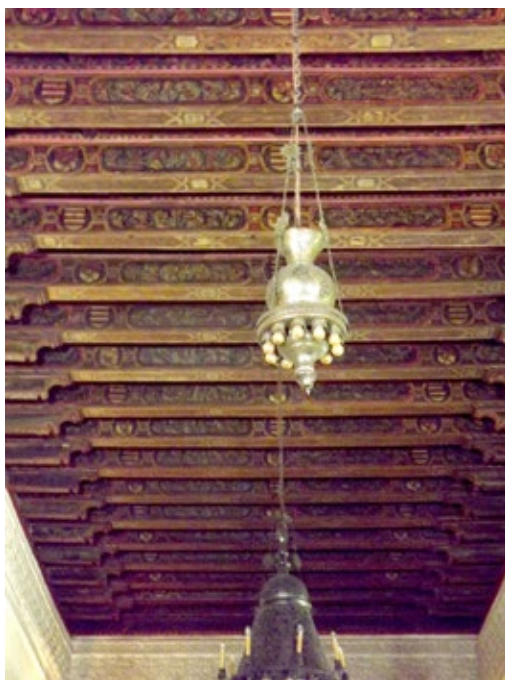
Figura 4. Vista general del alfarje de la Antecapilla del Palacio de las Dueñas (Sevilla). Entre finales del siglo XV y principios del siglo XVI. Fundación Casa de Alba.
