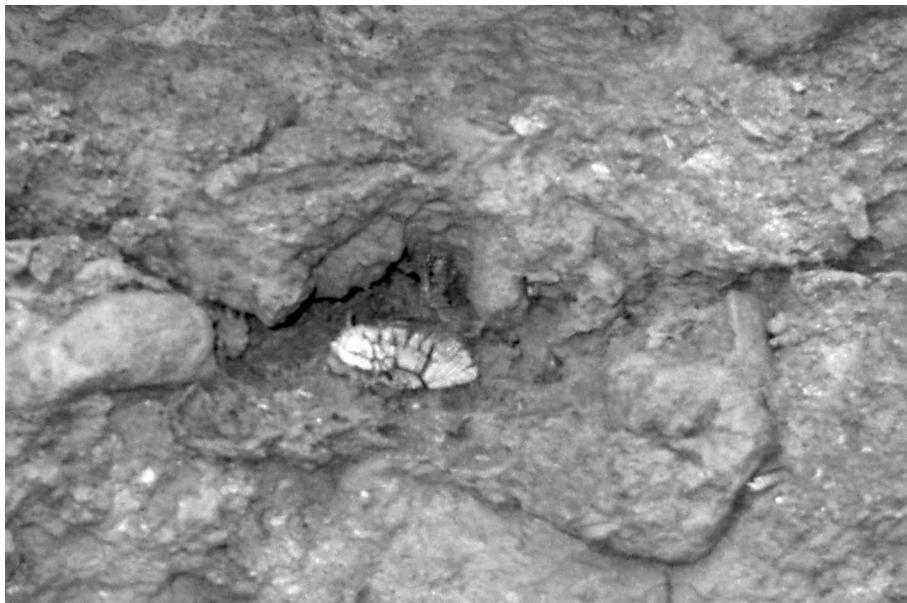
Figura 10. Detalle de aguja de reaprovechamiento en el Recinto de El Parque.
