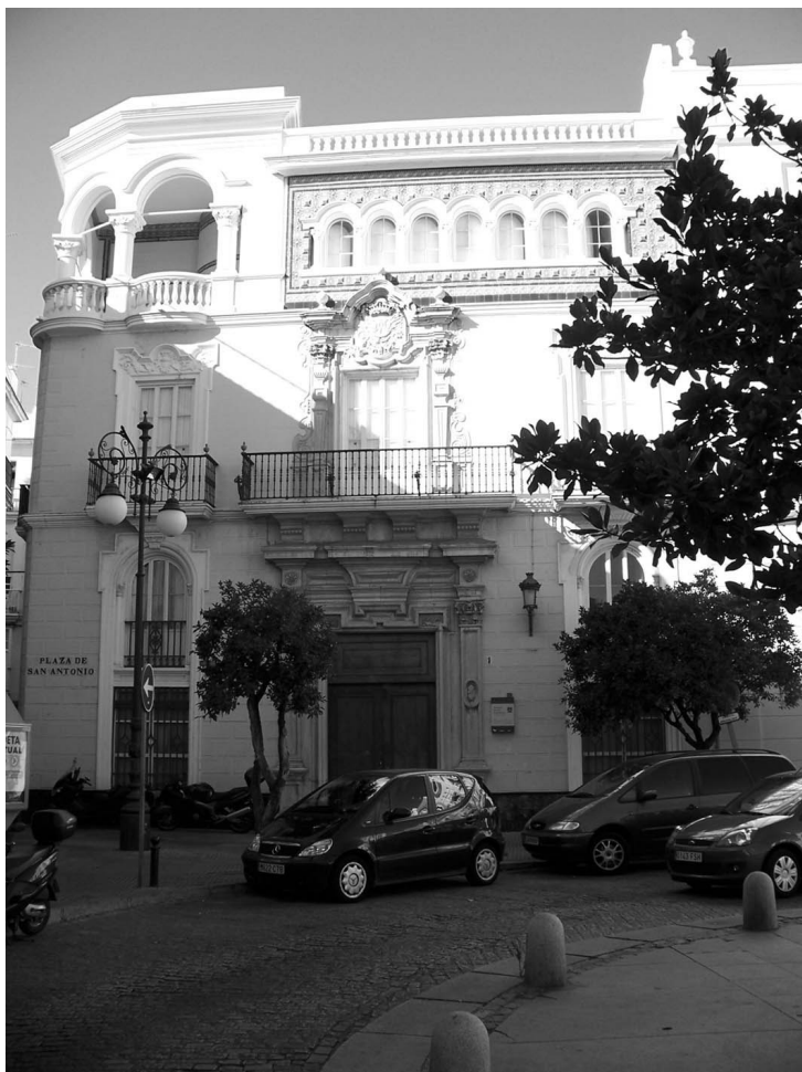
Figura 10. Ídem. Estado actual.
