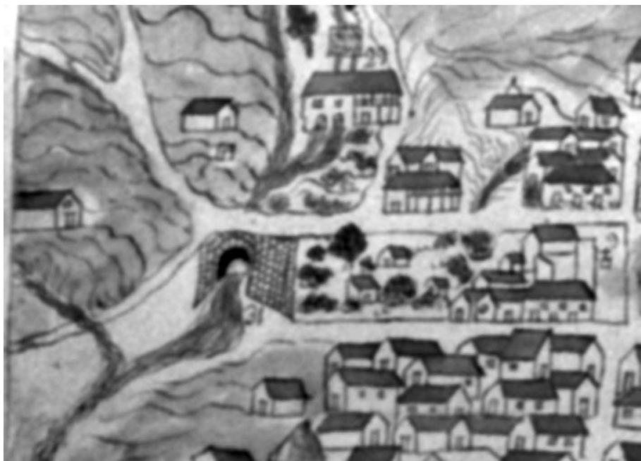
Detalle del Plano de Quito de Dionisio de Alcedo y Herrera, con el Puente sobre el río Machángara (31), citado por Alcedo y Herrera en su Plano geográfico e hidrográfico (1734, Archivo General de Indias, Sevilla).
