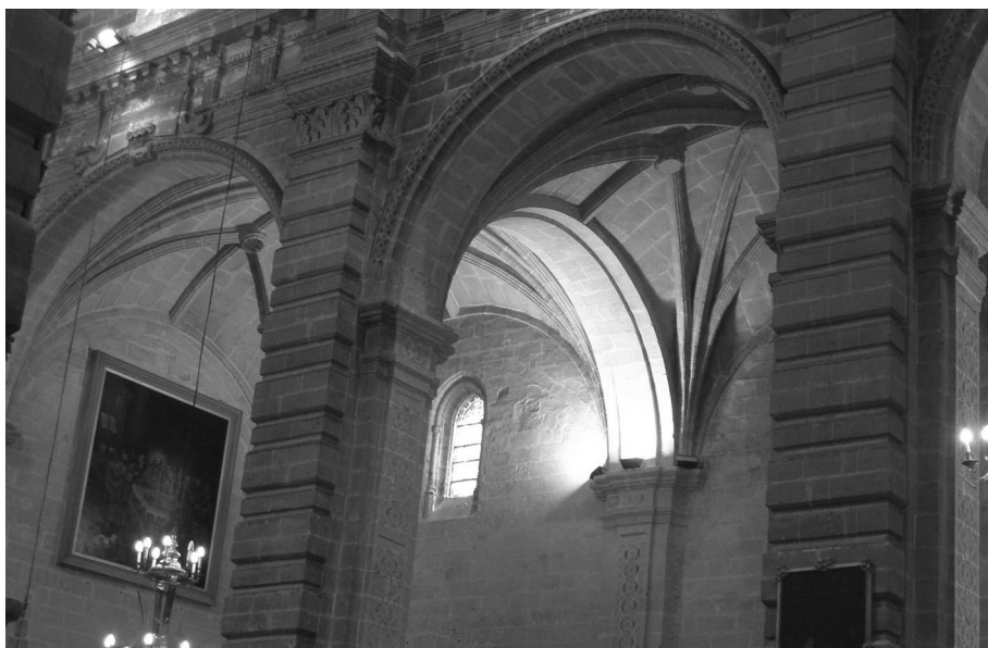
Figura 3. Antón Martín Calafate: Iglesia Prioral del Puerto de Santa María. Pilastras de la nave central y cubiertas de la nave del Evangelio hacia los pies.
