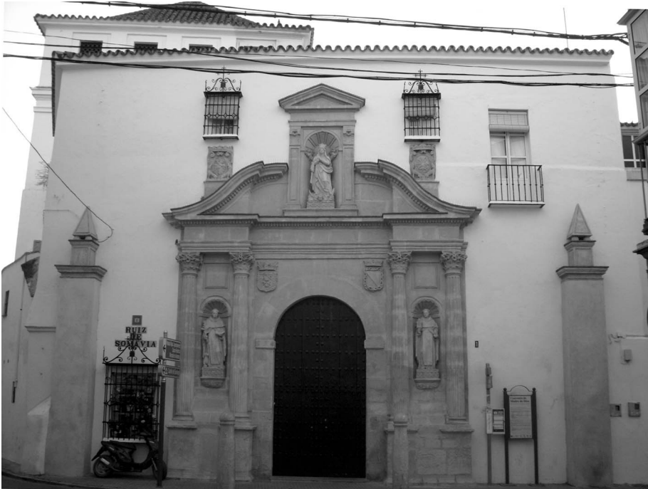
Figura 2. Portada de la portería. Convento de Madre de Dios. Sanlúcar de Barrameda.
