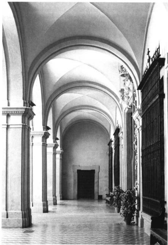
Galería y cubiertas.
