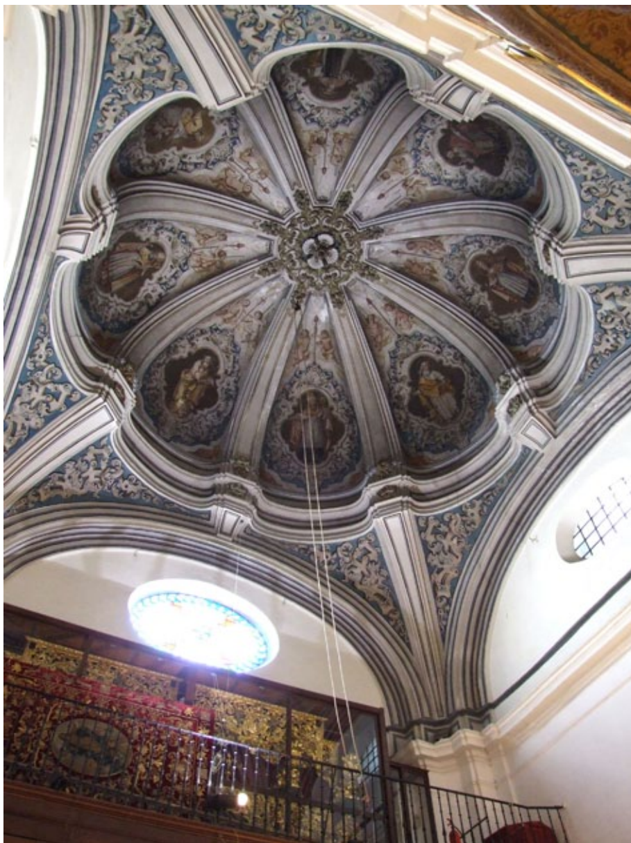
Fig. 4. Cúpula y coro alto de la capilla de San Andrés.
