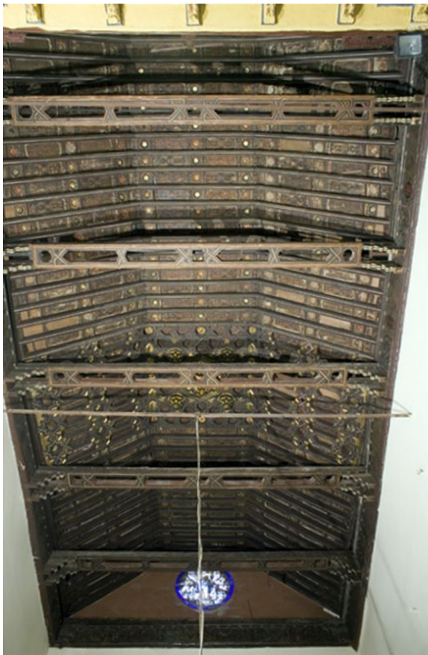
Fig. 1. Armadura de la iglesia de Santa María del Socorro. Sevilla.
