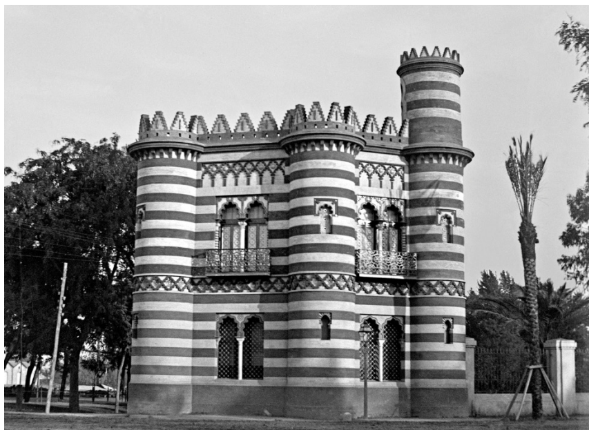
Figura 8. Pabellón de ángulo, construido h. 1894. © ICAS-SAHP, Fototeca Municipal de Sevilla, archivo Caparró (ca4_498).
