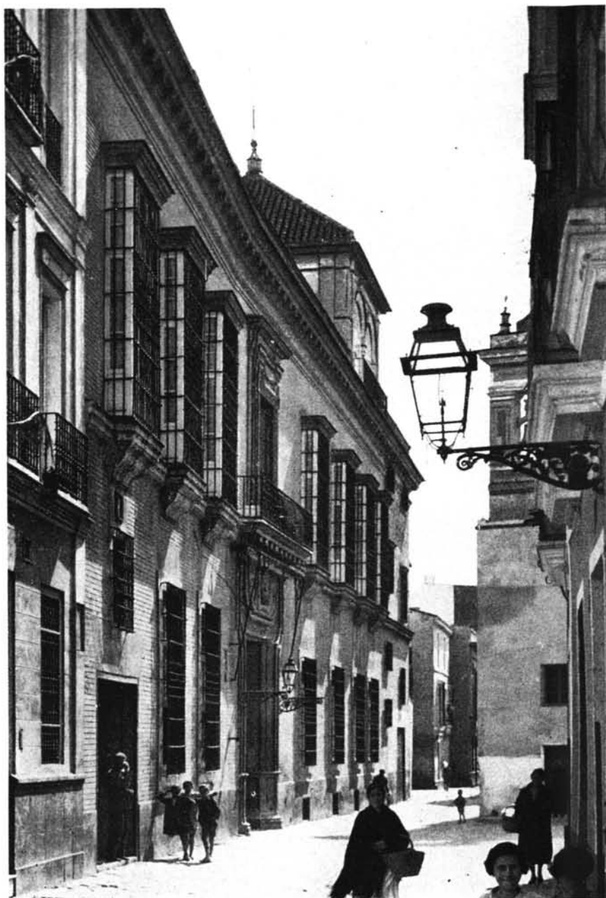
Torreón del XVIII de la antigua casa del almirante López Pintado, conocida como de los marqueses de Villapanés y Torreblanca del Aljarafe en el barrio de los Acipreses
