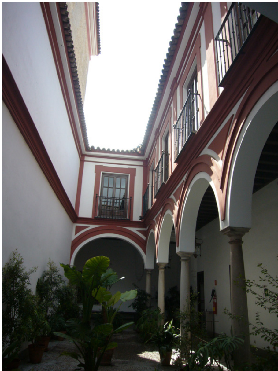
Figura 3. Patio y galería existente tras la cabecera de la iglesia. Foto: Teodoro Falcón Márquez.
