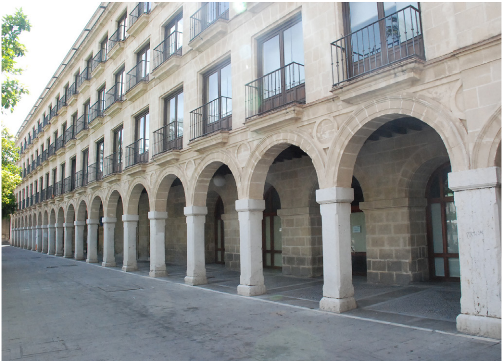
Figura 3. Soportales con pilares de piedra de Gizonza, reformas tras el incendio de 1794, antigua Alhóndiga y Panadería, Jerez de la Frontera.
