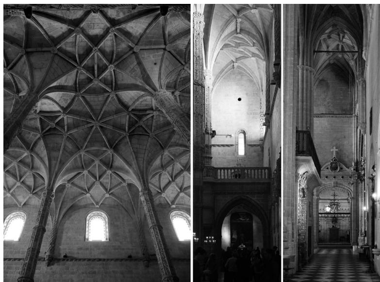
Figura 8. a) Interior de las naves , iglesia de los Jerónimos, Belém (Portugal); b) Detalle del derrame de sus bóvedas sobre el muro lateral , iglesia de los Jerónimos, Belém (Portugal); y c) Detalle similar , iglesia de Santa María, Arcos de la Frontera (Cádiz).
