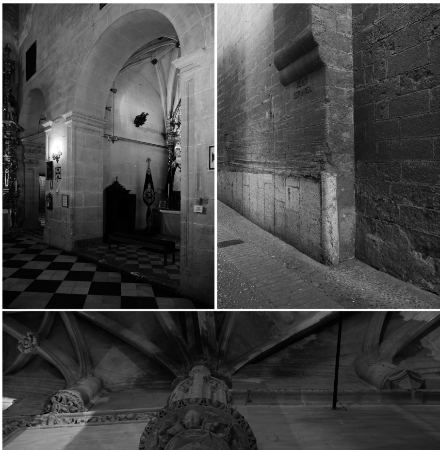
Figura 3. a) Embocaduras de la sacristía y de la primera capilla de la Epístola; b) Retranqueo del muro lateral de la iglesia en el callejón de las Monjas; y c) Discontinuidad geométrica en los paramentos de los dos primeros tramos, iglesia de Santa María, Arcos de la Frontera (Cádiz).
