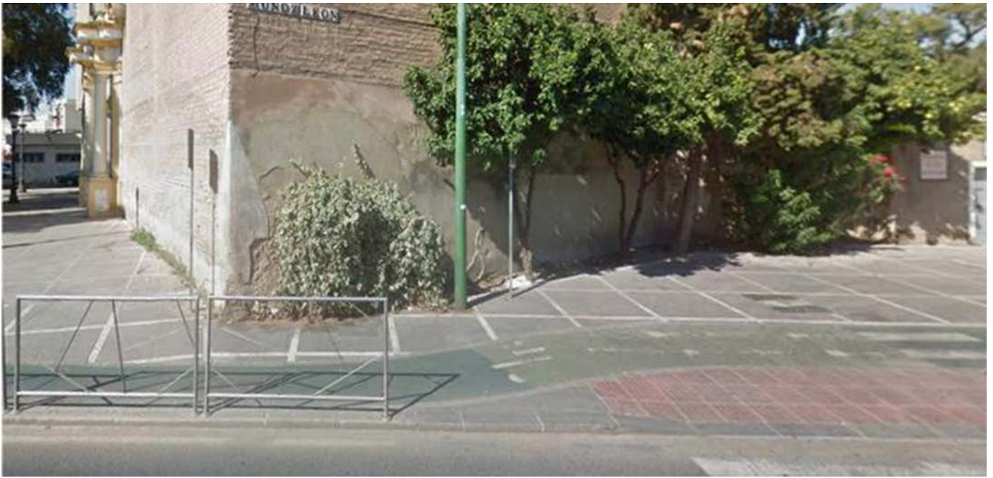
Figura 2. Carril-bici en calle Muñoz León. Previamente el acerado era mucho más estrecho y era ocupado en su totalidad por un angosto carril-bici que lindaba con la esquina sobresaliente del edificio, haciendo imposible el paso de un peatón y una bicicleta al mismo tiempo y propiciando posibles atropellos. El nuevo trazado gana espacio a la calzada, permitiendo un leve desvío del carril-bici y destinando al paso peatonal el espacio que antes ocupaba la vía ciclista. Para la resolución del problema, se mantuvo la angostura del carril-bici. Foto recuperada de Google Maps.
